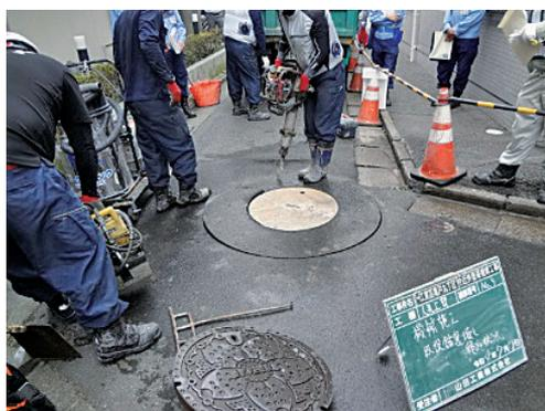
●円形球面切断落下防止金具取付後にブレイカーで破砕
