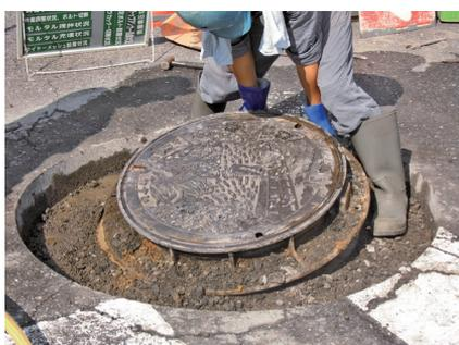
パラボラカッターで切断後、切断塊、鉄棒を撤去します。
