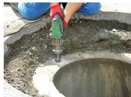
無振動油圧押し込み式アンカー。
