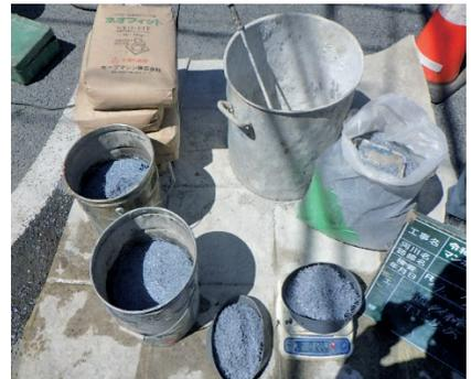
現場にスケールを持ちこんで適合量を計測して打設必要量を一気に小分けしてスムーズで正確な打設になるよう心がけています。
